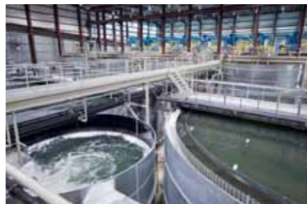
VERWERKING VERVUILDE BAGGERSPECIE
